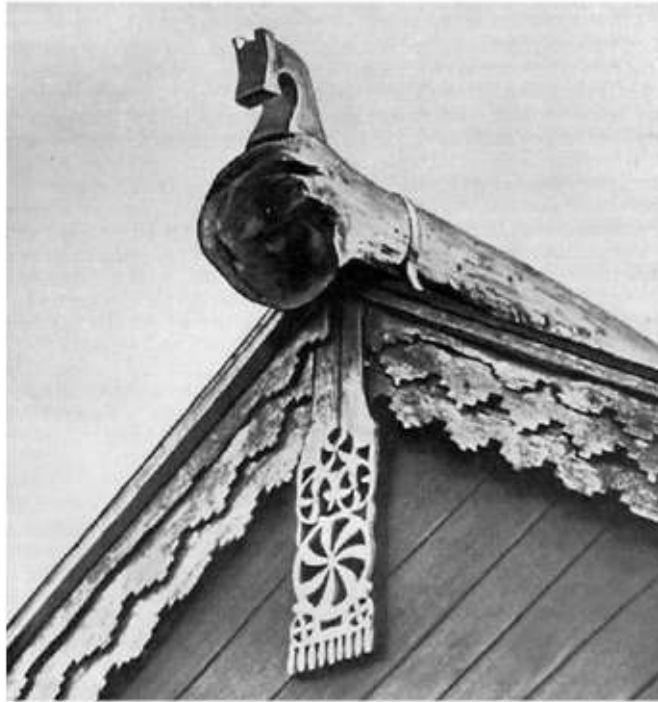
«ГРОМОВЫЙ ЗНАК» ПОД КОНЬКОМ КРЫШИ. Север
